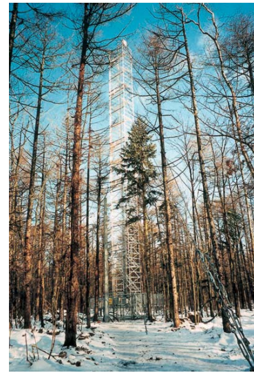
フラックス観測塔 (41m高)
