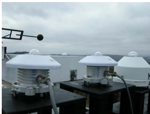
設置台製作状況
